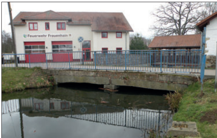
Aktueller Zustand „Brücke über die Große Röder an der Feuerwehr“
